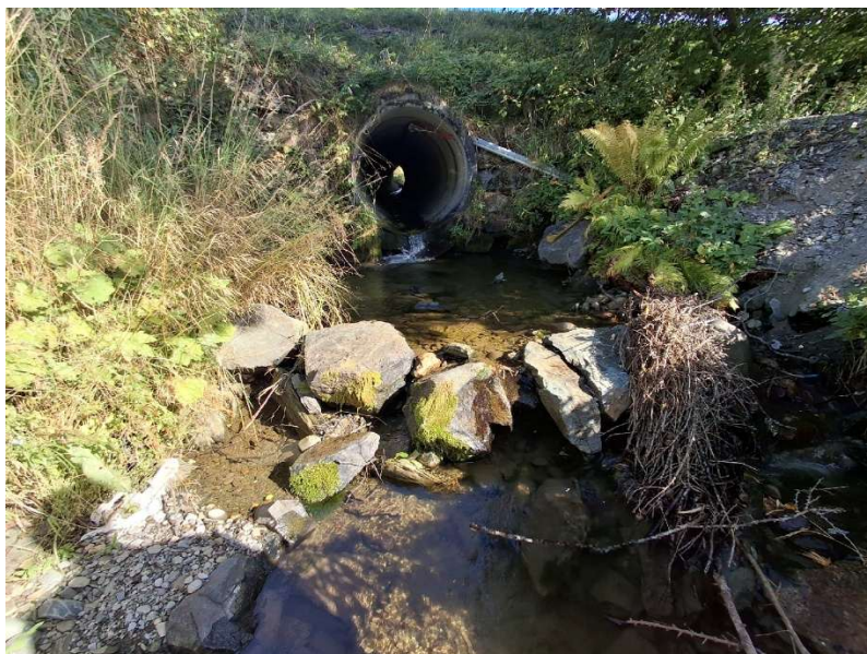
Terskel og kulvert under E14 i Nygårdsbekken, Meråker.
