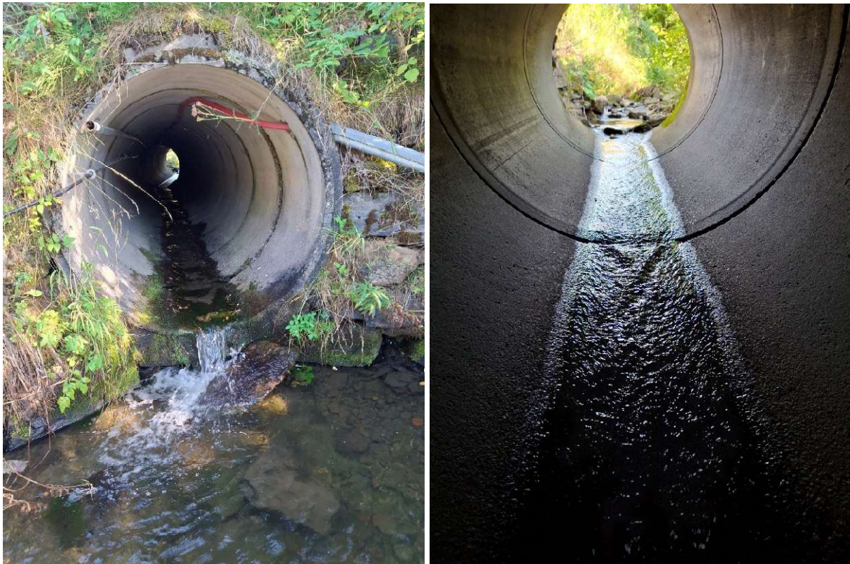
Figur 15. Bildet til venstre viser utløpsområdet til kulvert under E14 i Nygårdsbekken. Bildet til høyre er tatt inne i kulverten På befaringsstidspunktet hadde kulverten under E14 en vanddybde på 4 til 9 cm (Figur 15). Helningen på kulverten ble ikke målt, men slik denne er etablert ser kulverten ut til å være vandringshindrende for fisk ut fra for lav vanddybde og/eller for høy vannhastighet.
