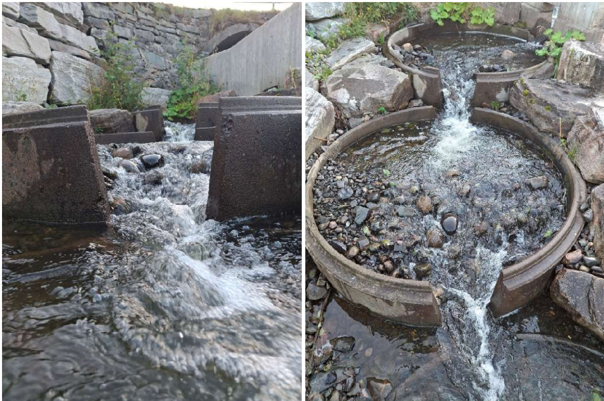
Figur 10. Nedre deler av fisketrappa i Kvernbekken
