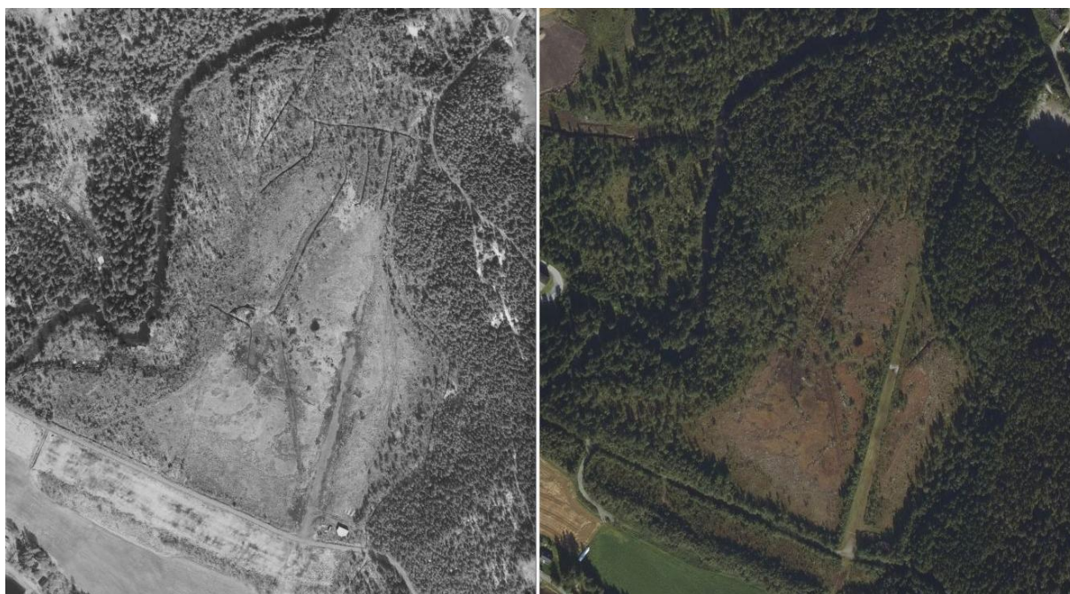
Figur 20. Ålesmoen. Ortofoto fra 1998 (t.v.) viser tydelig grøftene som har blitt gravd for å drenere dette myrområdet. Bildet fra 2021 (t.h.) viser tydelig gjengroinga i de grøftede områdene, samt hele lengden på den utfylte rullebanen. Foto: Kartverket/Norgebilder.no.
