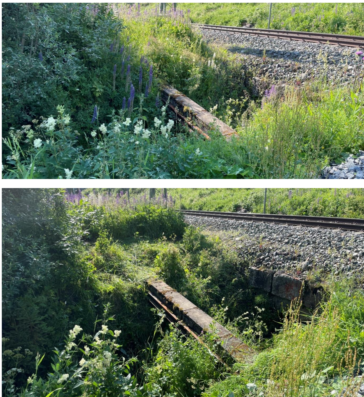
Figur 17. Nedstrøms kulvert under jernbanelinja ved Øyen før (øverst) og etter (nederst) luking.
