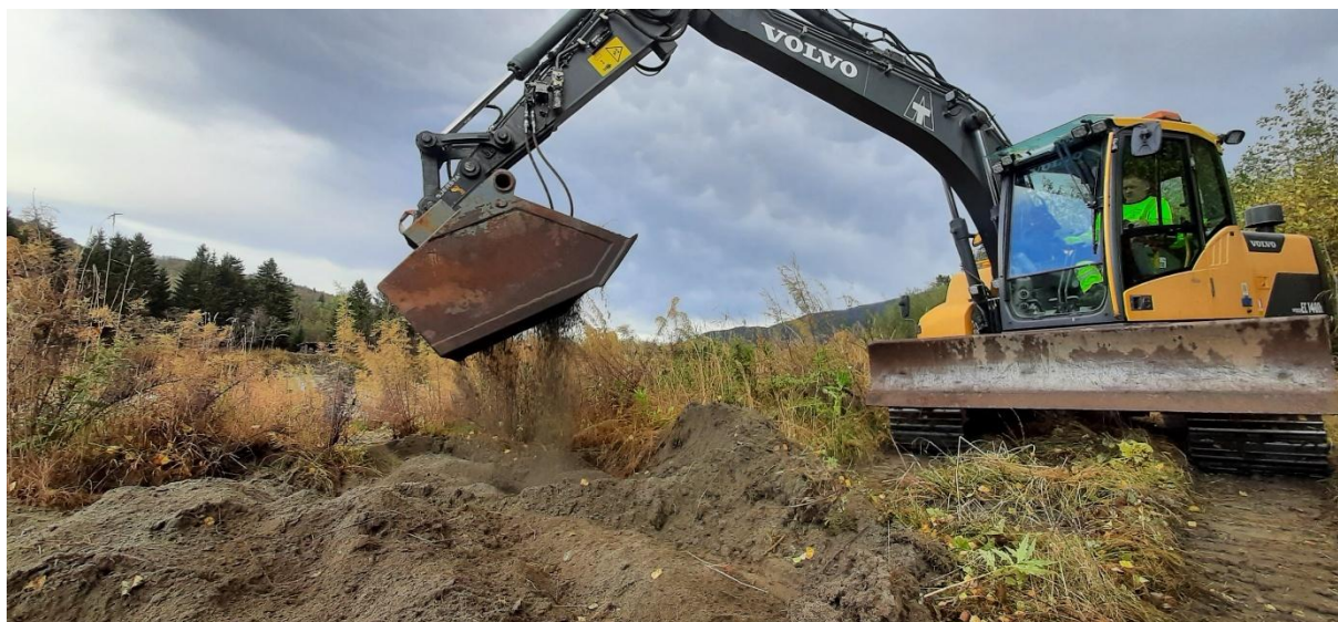
Figur 48. Gravemaskin med sorteringsskuff ble brukt for å riste sanda løs fra vegetasjonen.
