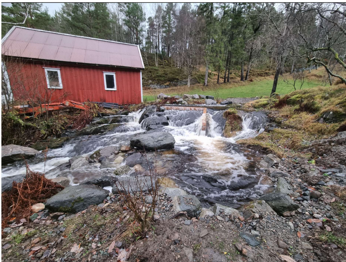
Figur 15. Svaberget etter tiltaksgjennomføring. Bildet er tatt ved høy vannføring.
