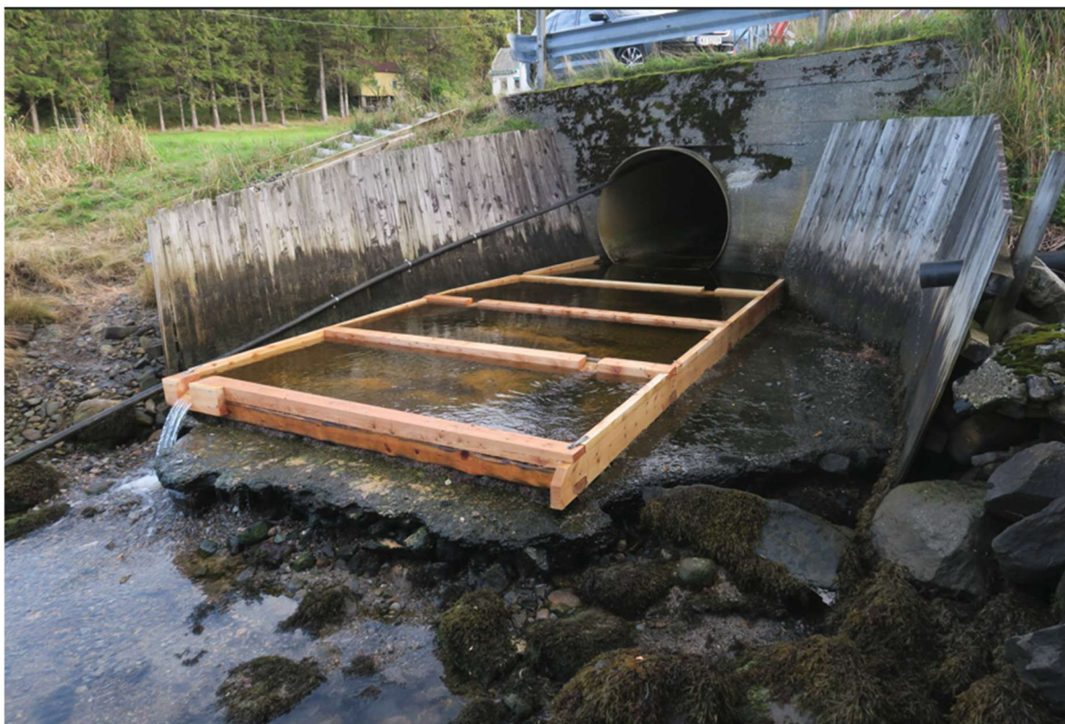
Figur 4. Kulverten «Balen» med betongplate etter tiltaksarbeider 2025, ved lav vannføring.
