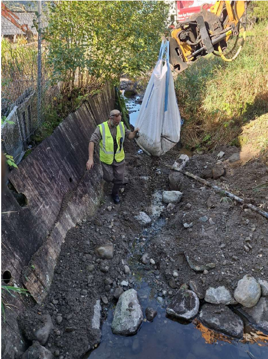
Figur 11. Utlegging av gytegrus. Foto er tatt av entreprenør Stein Åge Rangnes.
