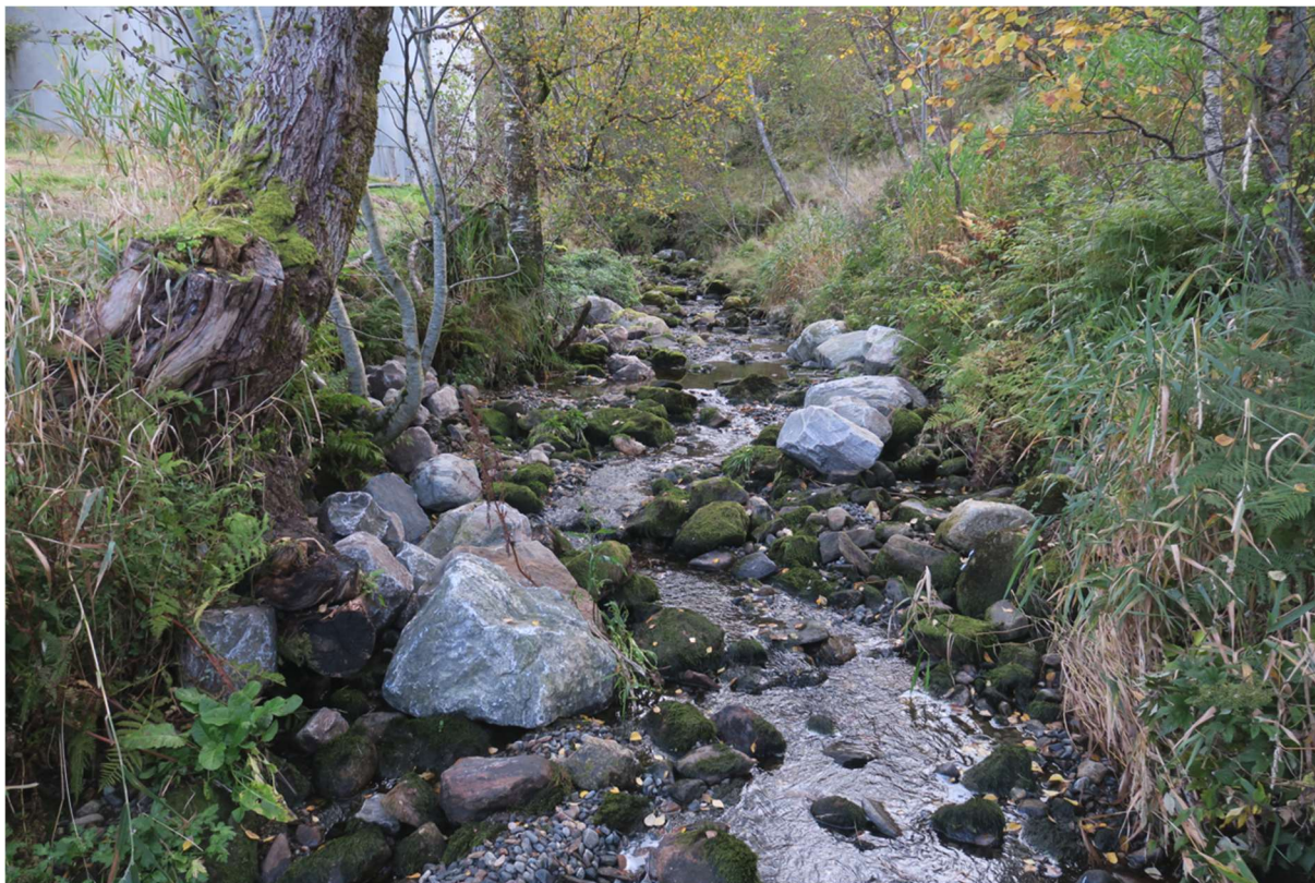
Figur 9. Grov stein lagt ut for å styre vannstrømmen og få elva til å grave ut «dypål» på parti hvor elva før tiltaksarbeider var bred og grunn på lav vannføring. Hensikten var å beholde konnektivitet for fisk ved lav vannføring.
