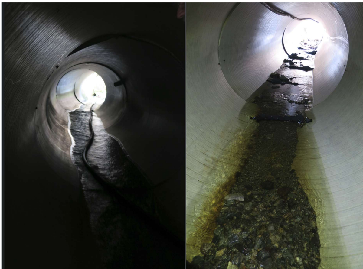
Figur 5. Bildet til venstre viser kulverten «Balen» før tiltaksarbeider. Bildet til høyre viser «Balen» etter tiltaksarbeider 2025.
