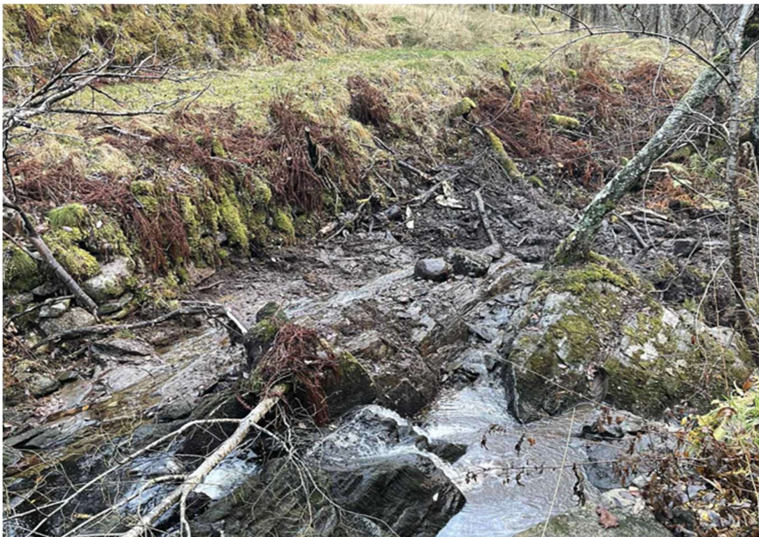
Figur 22. Fjellrenne forbi fossen nedstrøms «Inntakdammen» under rensk.
