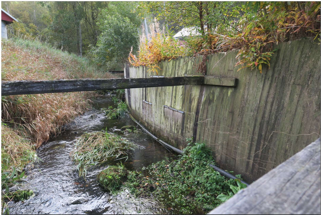
Figur 6. Elvestrekning oppstrøms kulverten «Balen» før tiltaksgjennomføring.
