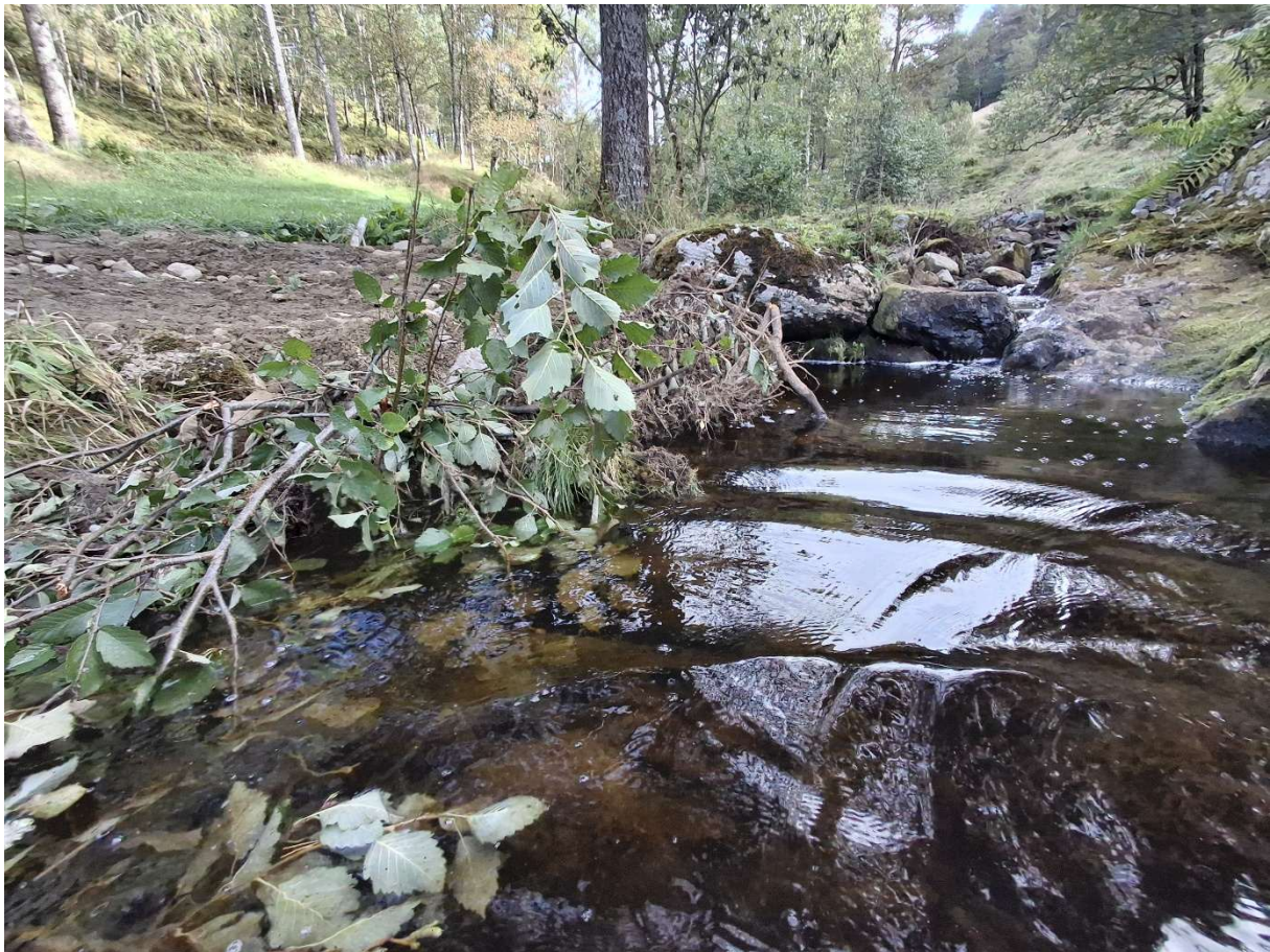
Figur 16. Stokk gravd ned i elvebredden, med rotenden liggende ute i elva.
