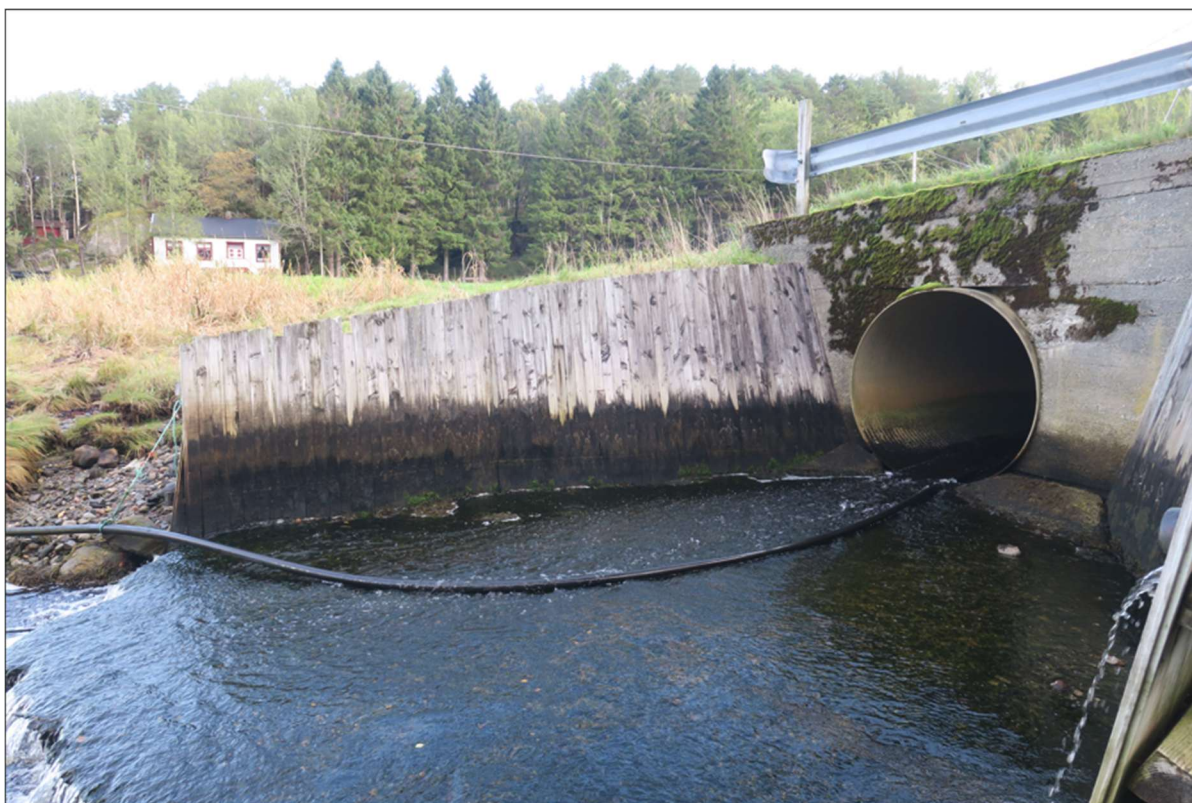
Figur 3. Kulverten «Balen» med betongplate før tiltaksarbeider
