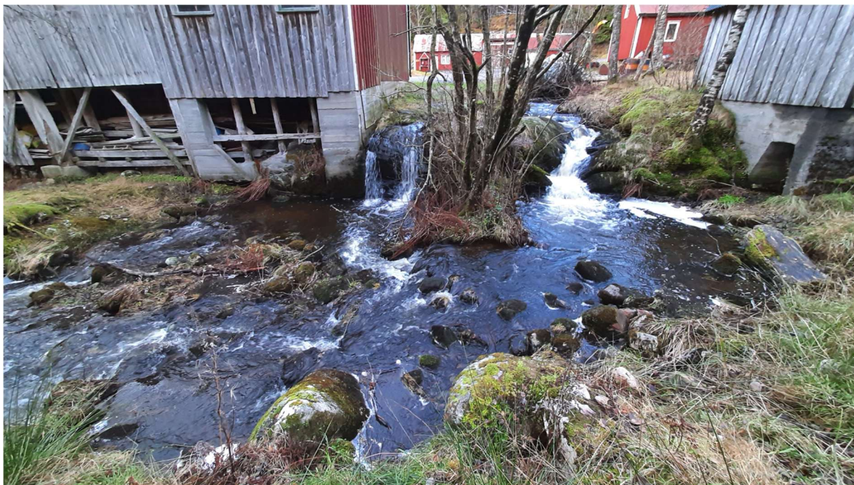
Figur 12. «Åldammen» før tiltak, ved middels til høy vannføring. Fossen til venstre har forholdsvis høyt fall og lav vanndybde over fjellterskelen. I kulpen under hvitstryket til høyre er det begrenset vanndybde og en fjellterskel som ligger like under vannflata (sees på bildet som en oppstuvning av vannet).
