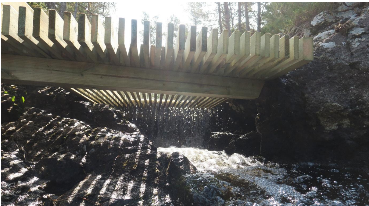
Figur 8. Vannstrømninger gjennom den ferdige oppgangssperra ved lav vannføring.
