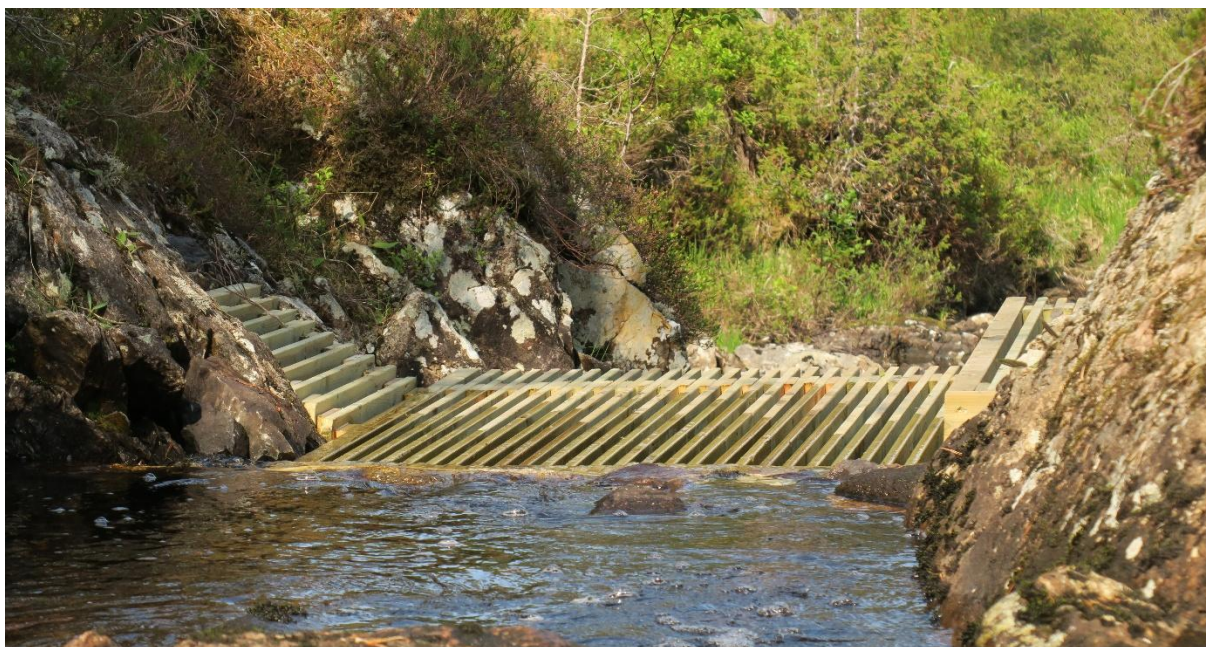
Figur 7. Før (øverst) og etter (nederst) tetting med stein mellom elva og oppgangssperra.
