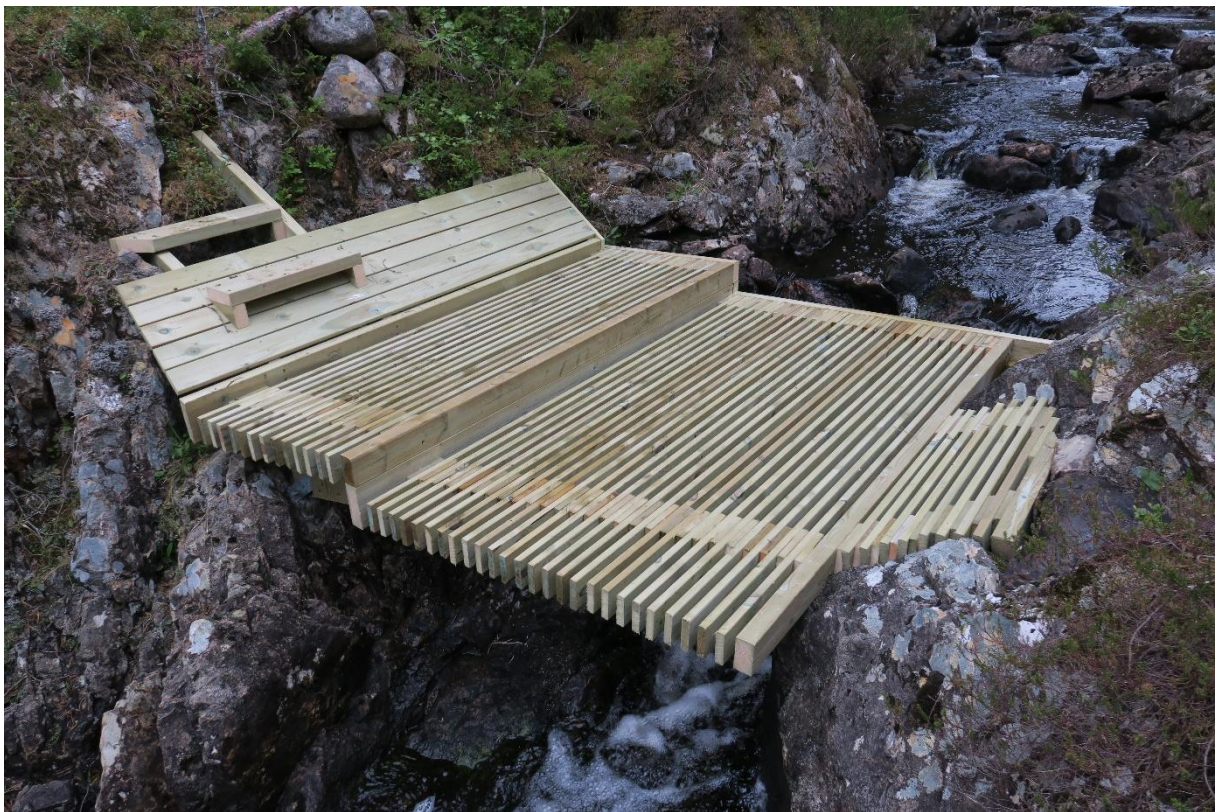
Figur 6. Ferdig trekonstruksjon. Lengden på oppgangsperra er ca. 220 cm
