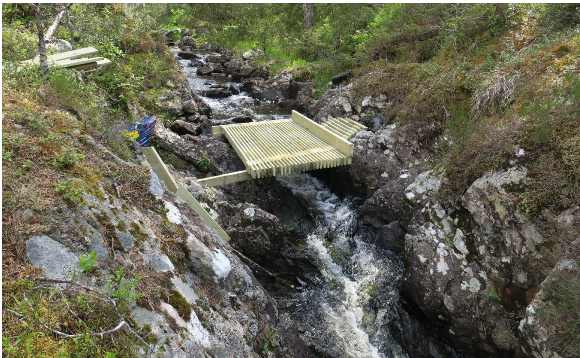
Figur 4. Oppgangssperra under bygging.
