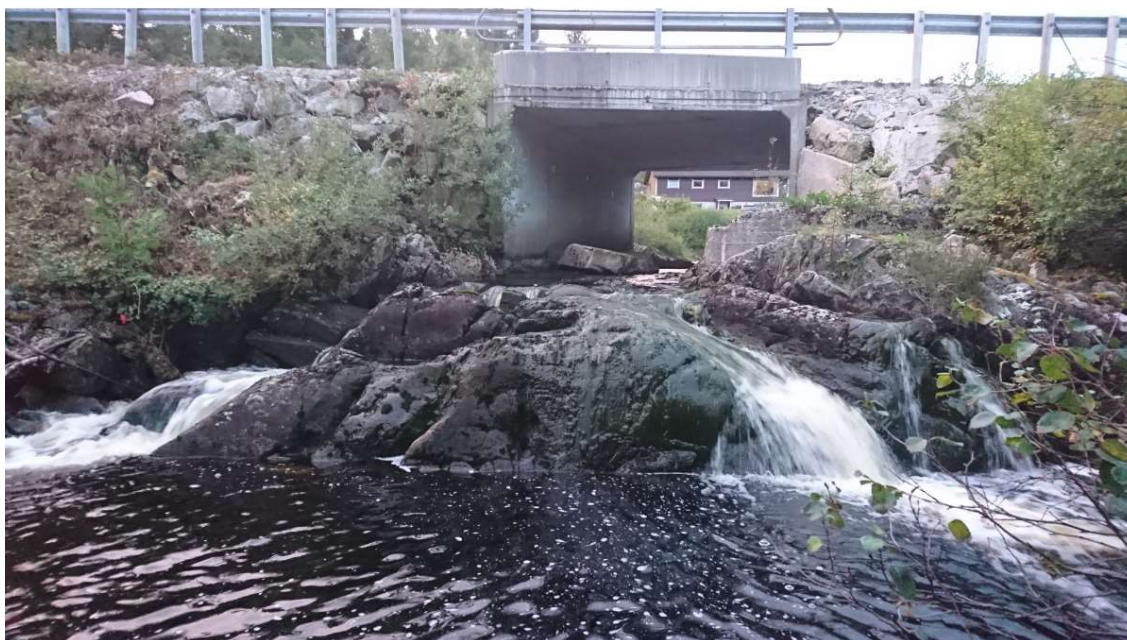
Figur 25. Figuren viser kulvert under Fv. 713.
